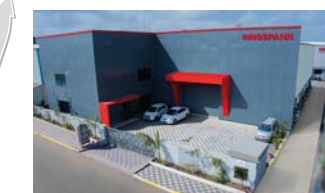
RINGSPANN Power Transmission India Pvt. Ltd., Indien
