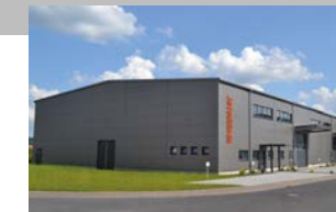
RINGSPANN StS GmbH, Deutschland Werk Präzisionskupplungen
